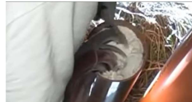
Opskumning af blyrør med teknikboks for at gøre det lufttæt
