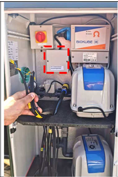
Trin 3. Tilslut de tre elektriske kabler til samledåsen som beskrevet i næste afsnit. Kablerne vedrører (1) indløbspumpen, (2) svømmeren og (3) doseringspumpen.
