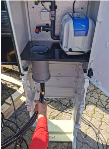
Trin 1. Før rør og kabler gennem huller i bunden af teknikboksen
